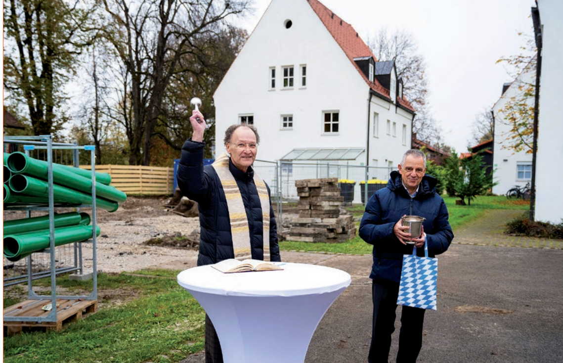
Generalvikar Dr. Wolfgang Hacker segnet die Baustelle
